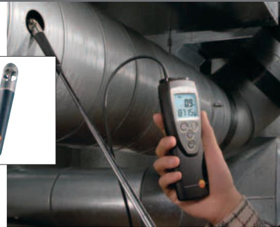
Control de la velocidad del aire en conductos de aire acondicionado
